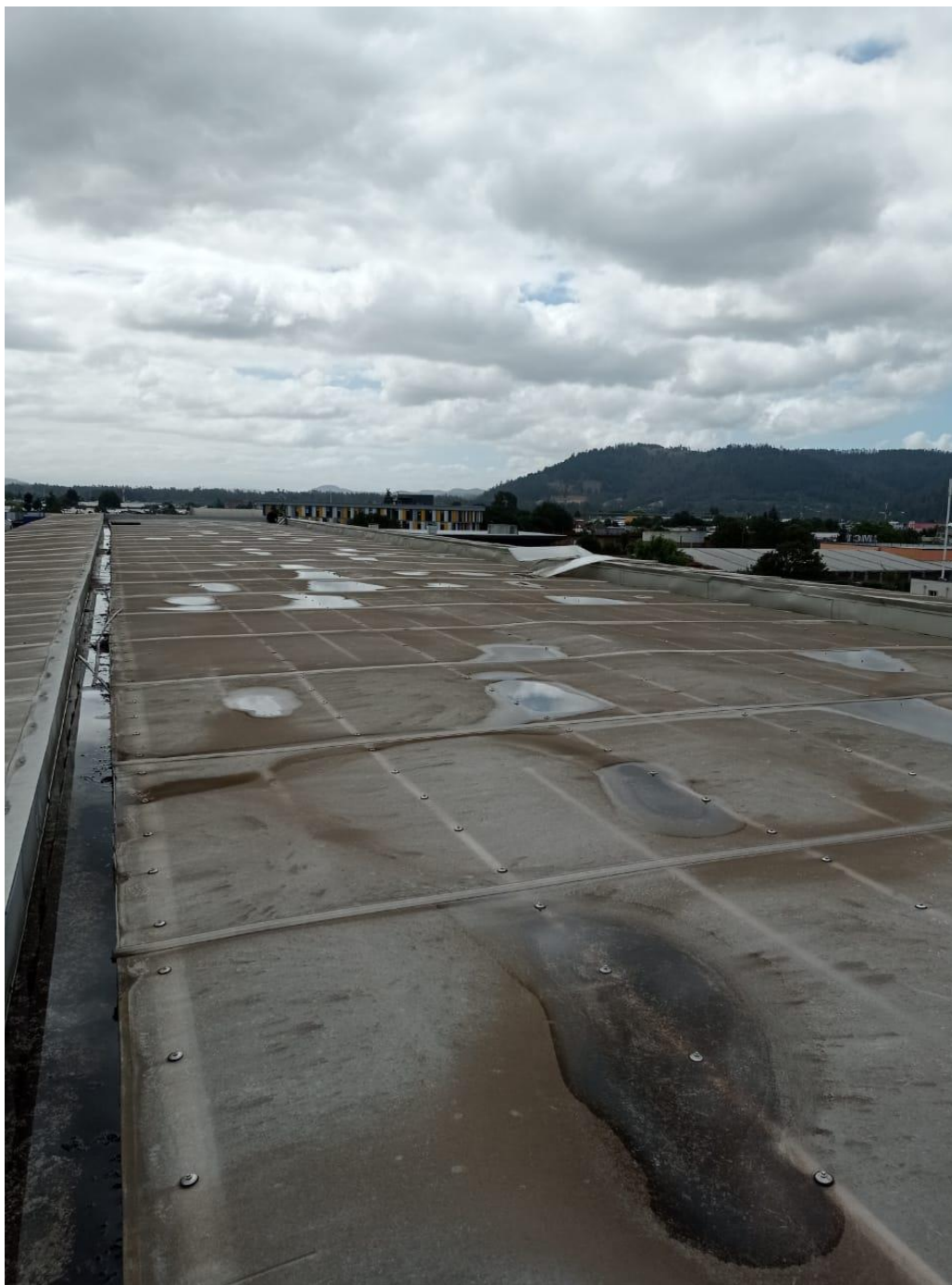
FOTOGRAFIA REFERENCIAL SECTOR GENERAL, AREA NO INTERVENIR
