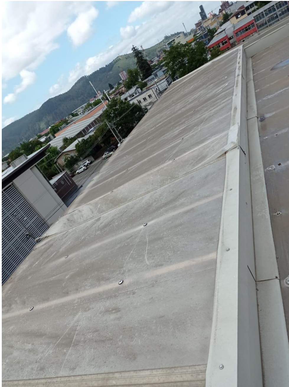
FOTOGRAFIA REFERENCIAL SECTOR ESTE , AREA PERIMETRAL A INTERVENIR
